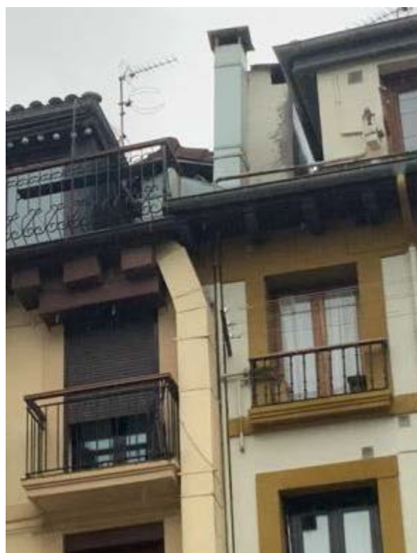
Fotografías 7 y 8. Ejemplos de conductos de extracción de humos adosados a fachadas exteriores Fuente: Borrador del PEPCMPVP
