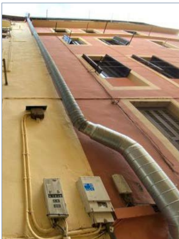
Fotografías 7 y 8. Ejemplos de conductos de extracción de humos adosados a fachadas exteriores Fuente: Borrador del PEPCMPVP
